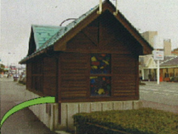
二万堂地下道
