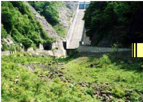
図 38 手取川ダムの維持流量放流前 （平成13年8月）
