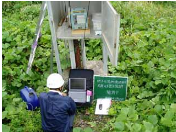
図 82 地下水位・流向観測
