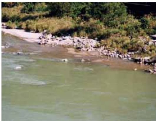
図 45 濁水とシルト質土砂の堆積状況
