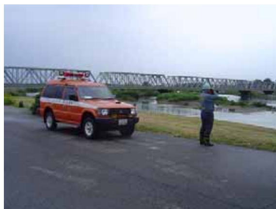
図 80 河川巡視（平常時）の状況
