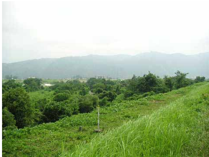
図 65 河道内樹木群の繁茂状況
