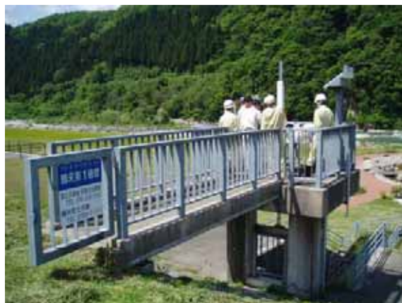
図 78 河川管理施設の点検
