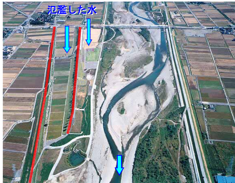
図 77 手取川 てとろがわ の霞堤 (川北町与九郎島地先 右岸 6.6k 付近)
