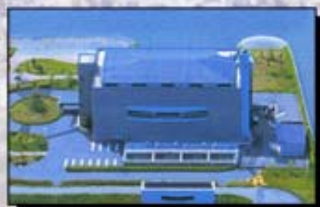
前川排水機場
