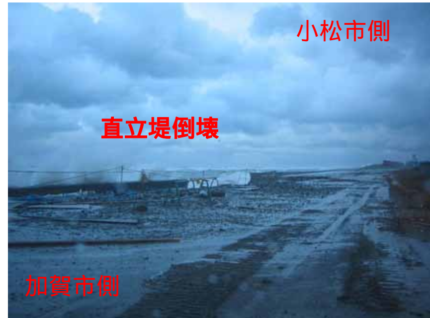
被災状況写真(H17.12.5未明撮影) 【小松市安宅新地先】
