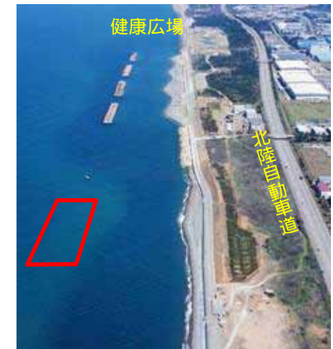
新型人工リーフ工事箇所
