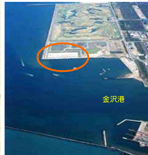
函体存置(製作済)箇所
