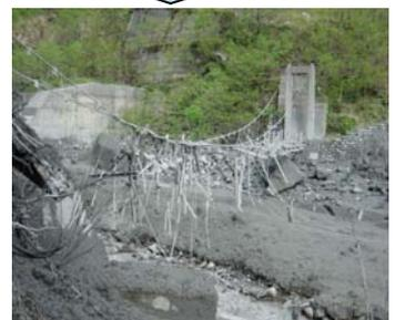
土石流により流失した吊橋
