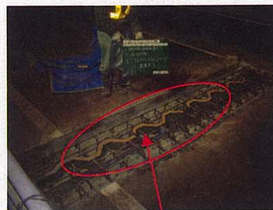
橋梁ジョイント部 コンクリート打込み箇所
