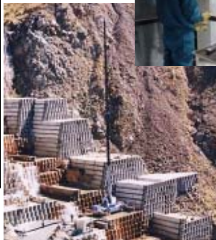
大型無人クレーン稼働状況
