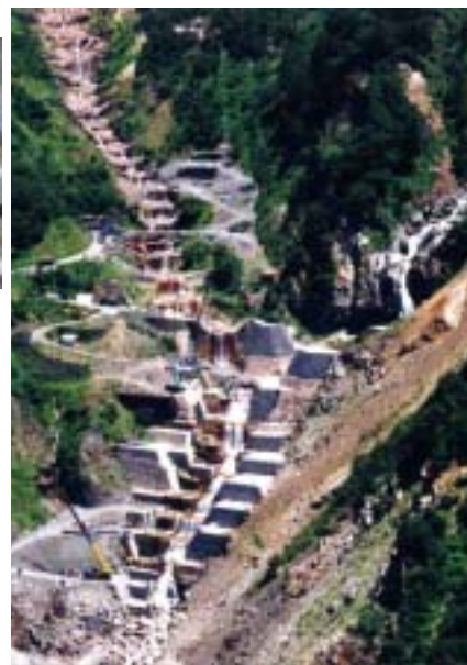
柳谷上流砂防えん堤群
