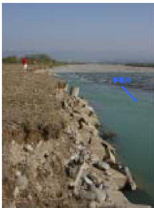
出水により被災した護岸
