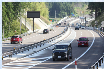
一般開通の状況（洲衛高架橋）
