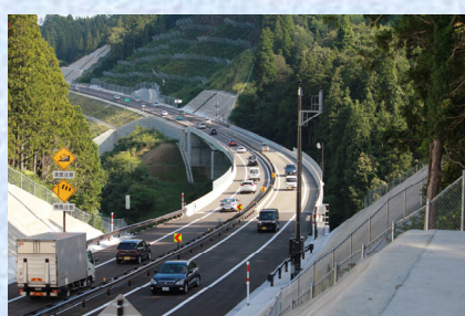
一般開通の状況（小泉高架橋）
