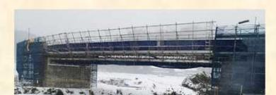
12月15日に橋桁の一括架設が無事に完了しました。架設時は輪島市役所の職員にも来ていただき、架設状況の見学や本橋の構造の特性についての説明を行いました。
