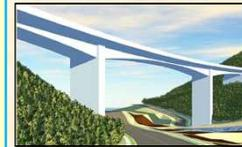
本工事は、輪島市三井町小泉地区で輪島道路本線と県道漆原下出線の交差箇所に、橋梁上部工事を施工します。橋梁はコンクリート橋で橋長は220mとなります。架設方法は「張出し架設」と呼ばれる工法で、橋脚からジャロベエが手を伸ばして行くように橋梁を構築します。施工期間中には、県道の交通規制も予定しております。事前に広報いたしますので、ご理解ご協力をお願いします。
