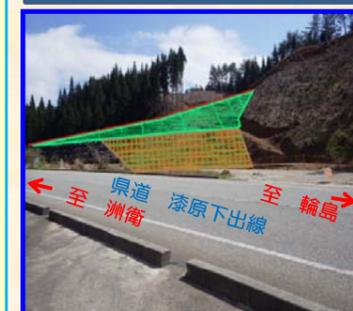
県道漆原・下出線の沿線において4月より測量始めてます。当工事は、掘削工が主な工種であり、土砂を搬出するために仮設道路の築造が急がれます。6月初めごろより本格的な施工に掛かりたいと思っております。秋ごろの工事完成を目指し安全第一に工事を進めて行きますので、皆様のご理解とご協力をよろしくお願い致します。
