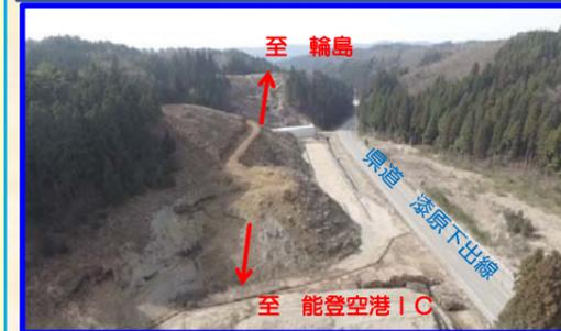
当工事は三井町小泉地区で切土工、路体盛土工、土質改良工、補強土壁工を行います。工事周辺、県道漆原下出線を通行される皆様に、出来るだけご迷惑をお掛けしないよう、細心の注意を払って作業を進めて参りますので、ご協力をよろしくお願い致します。
