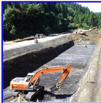
本工事は、能越道の盛土の中を横断するためのアーチカルバートボックスを構築する工事です。写真は、工事用道路の施工が完了して、構造物を構築するための掘削を行っているところです。工事期間中、安全面につきましては万全を期して行いますので、皆様のご理解とご協力をお願いいたします。
