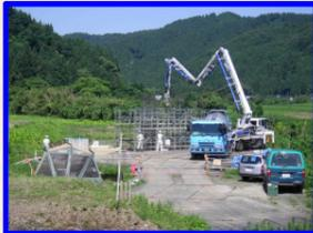
本工事は三井IC予定地にて本線橋の橋台1基、ランフ橋の橋台2基、河川の護岸を一部施工します。現在は、ランフ橋の橋台1基及び本線橋の橋台1基を施工しています。暑い日が続きますが、関係者一丸となって頑張っています。地域の皆様には、何かとご迷惑をおかけすると思いますが、何卒ご理解とご協力の程よろしくお願い致します。
