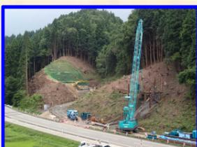
日頃より工事に関してご理解とご協力を賜りありがとうございます。先日から橋台の基礎杭の掘削作業を行い、一方では橋脚の掘削の為に土留め杭の設置作業を行っています。基礎杭の掘削に「発破(火薬)」を使用しており、その際には県道を一時的に通行止めとしています。今後ともご理解とご協力をよろしくお願い致します。
