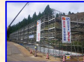
本工事は、能越道の盛土の中を横断するためのボックスカルバート(作業路 百成線)を構築する工事です。写真は、足場の組立が完了して、いよいよ構造物の施工に入るところです。
