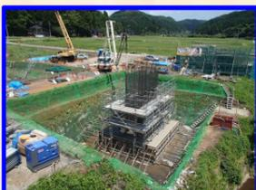
この工事は、能越道三井インター(仮称)で本線橋のA2橋台及びP1橋脚を築造する工事です。現在、P1橋脚を施工しています。工事期間中は、皆様のご理解ご協力の元、安全第一で工事を進めてまいりますのでよろしくお願い致します。
