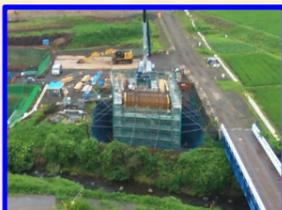
本工事は、能越道三井インター(仮称)のCランフ橋の橋台及び護岸を築造する工事です。現在 A-1橋台を施工しています。工事期間中ご迷惑をお掛け致しますが、ご理解とご協力を頂きますよう、よろしくお願い致します。
