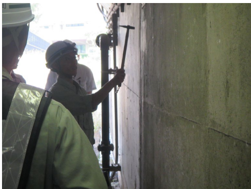
【打音検査の状況】
