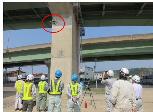
【ドローンを活用した点検状況】
