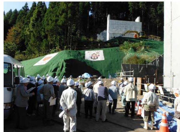
【小泉高架橋（仮称）下部工事現場見学の様子】
