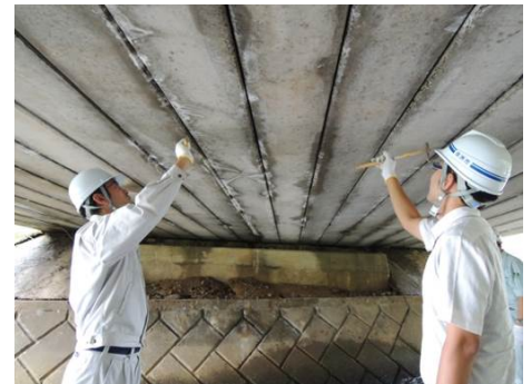
【橋梁点検診断研修（実習）】
