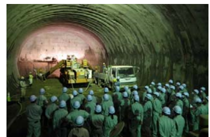
【御所トンネル（Ⅱ期線）工事施工状況の見学】
