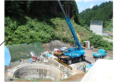
橋梁下部工(小泉地区)
