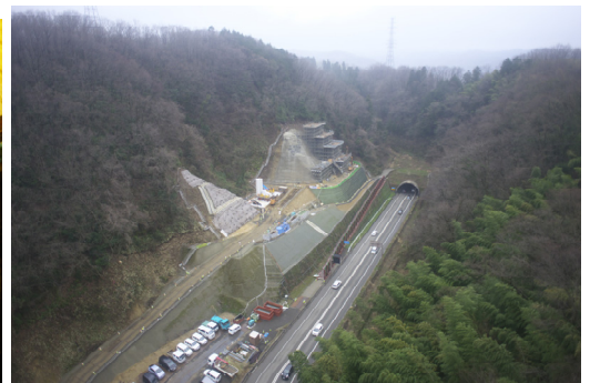
【御所トンネル起点側坑口付近】
