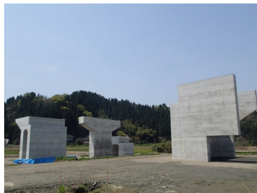
橋梁下部工(三井IC橋)
