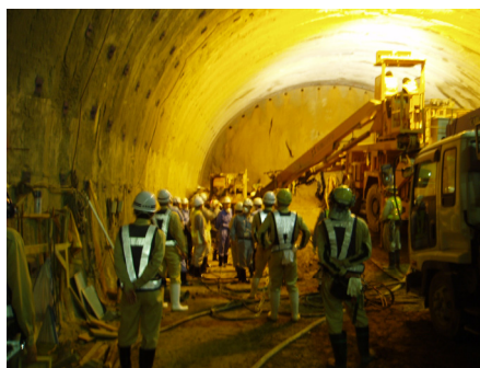
【神谷内トンネル(Ⅱ期)掘削工事】
