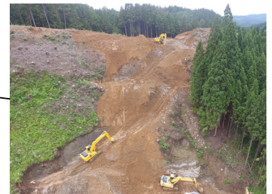
掘削工(小泉地区)
