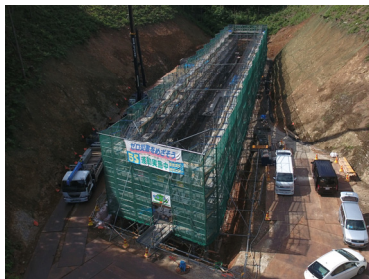
函渠工(小泉地区)
