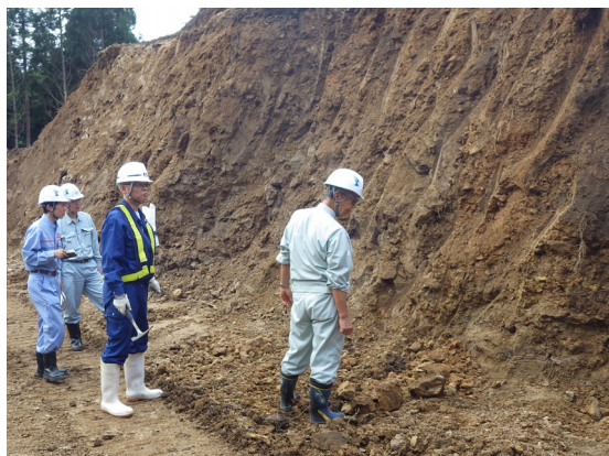
【切土箇所の地質状況の確認】
