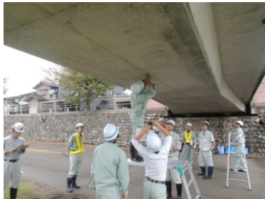
【新御影橋】 自治体職員を対象にした 橋梁点検研修 平成27年10月1日
