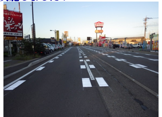
【減速マーク設置後の状況】
