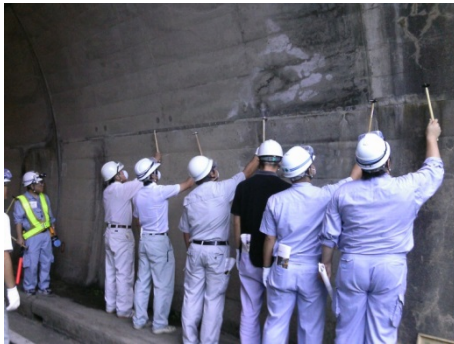
【テストハンマーによる打音点検（郷橋トンネル）】
