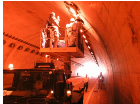
【高所作業車上の近接目視点検（平谷トンネル）】
