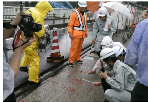
テストハンマーによる打音調査
