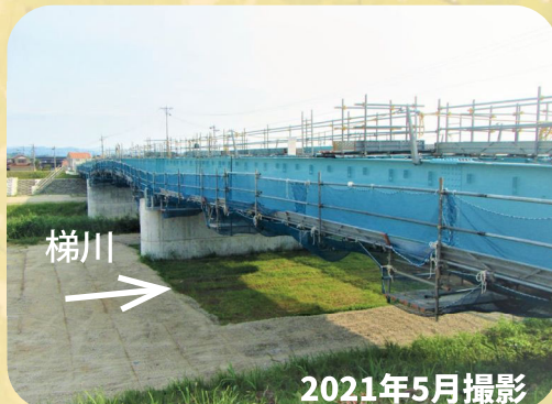
新しい能美大橋の橋桁(右岸上流より)
