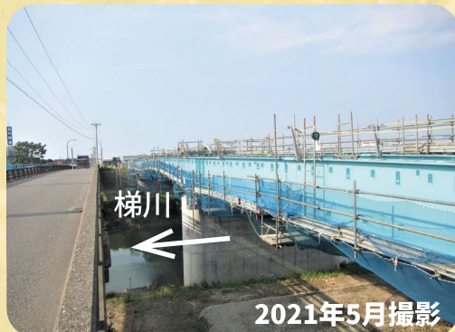
新しい能美大橋の橋桁(左岸下流より)
