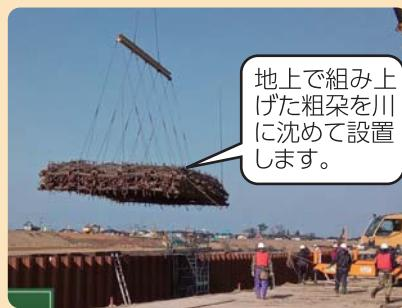
この工事でも、vol.73で紹介した伝統工法の粗朶沈床(そだちんしょく)が使われています。
