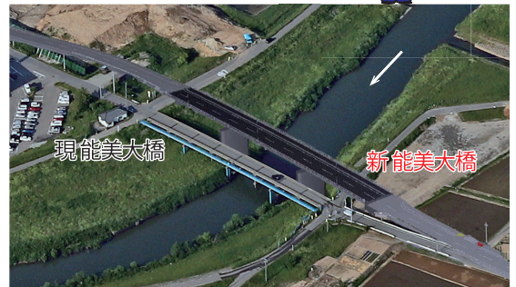
能美大橋完成イメージ（現在の橋梁は完成後に撤去）
