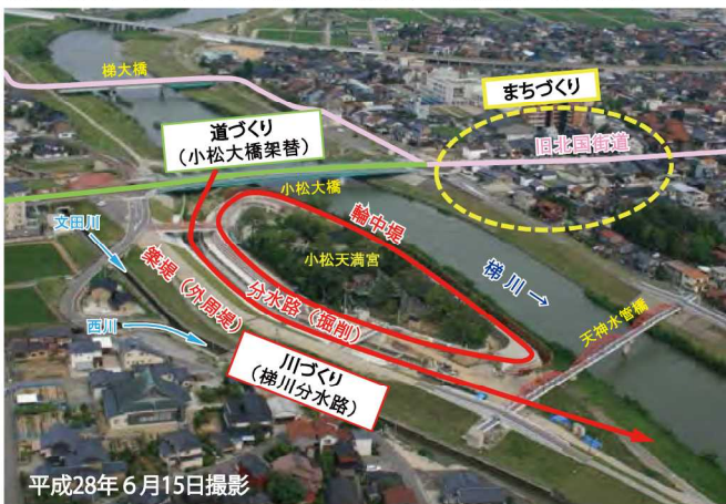
梯川分水路概要 整備内容：輪中堤 L=約480m、分水路(掘削) L=約210m、築堤(外周堤) L=約440m その他 小松大橋架替、天神水管橋架替、市道付替、水路付替、排水涵管など 事業着手：平成12年度～平成28年度 総工事費：約62億円
