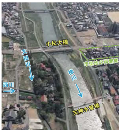
分水路改修の着手前
