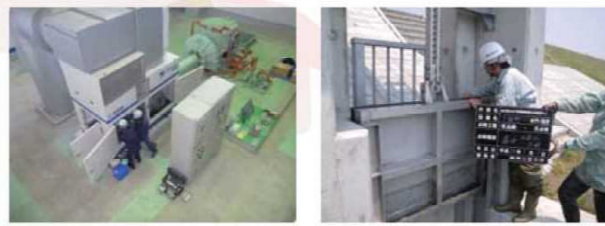
河川管理施設の点検状況
