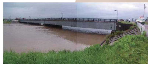
平成 25 年 7 月洪水の白江大橋付近の水位上昇状況
