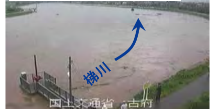
古府町 (右岸 8.0km 付近) での河道状況
