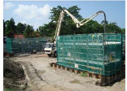
③ 梯川市道橋梁下部工事
