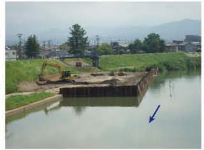
① 梯川川辺低水護岸工事
