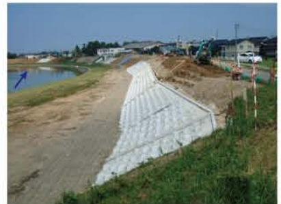
⑤ 梯川平面築堤護岸工事
