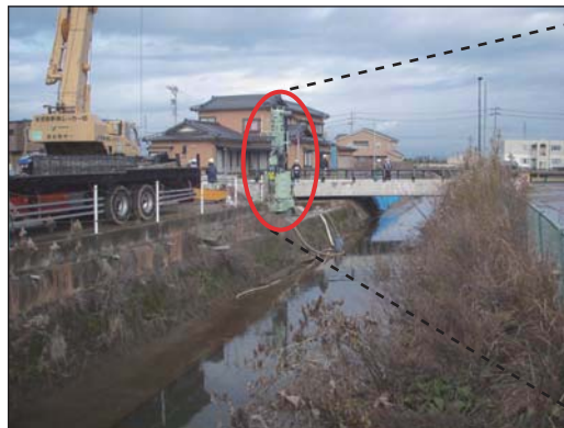
新送水管の切り替え工事
