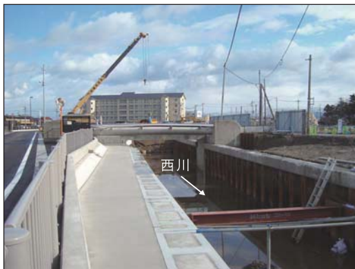
西川の付け替え工事
