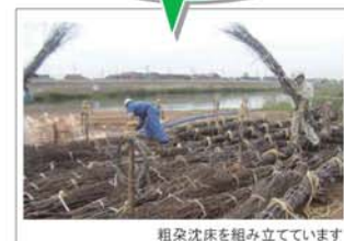
粗朶沈床を組み立てています
