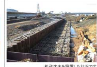
粗朶沈床を設置した状況です
