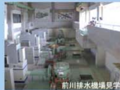
前川排水機場見学
