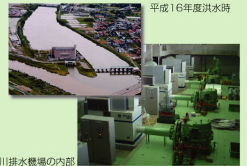
前川排水機場の内部
