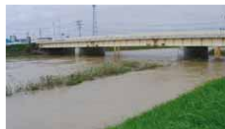
出水で指定水位を超えた梯川の状況（小松大橋付近）
