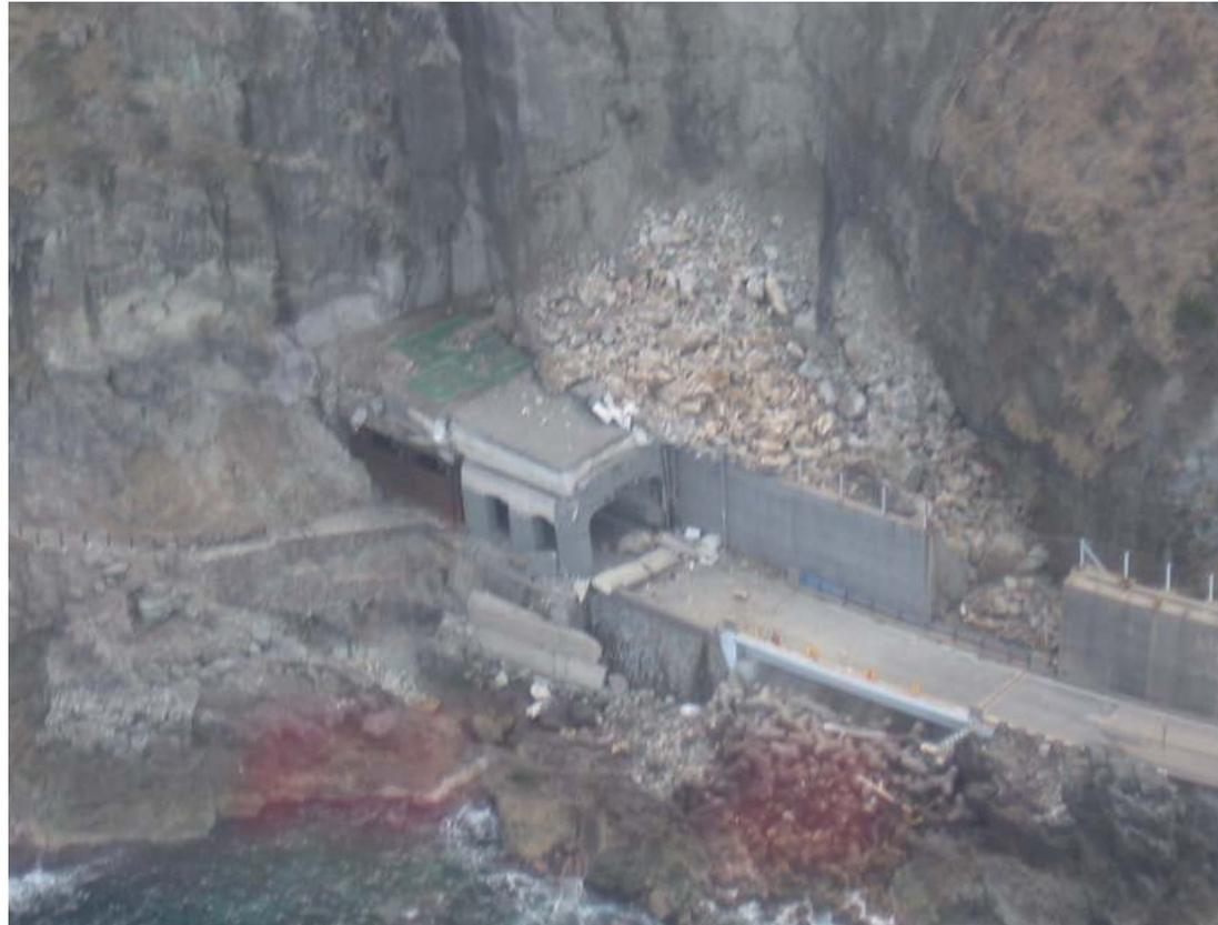
上部からの岩盤落下で洞門が被災
