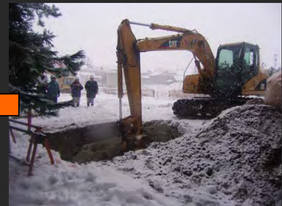
地盤改良：固化材攪拌
