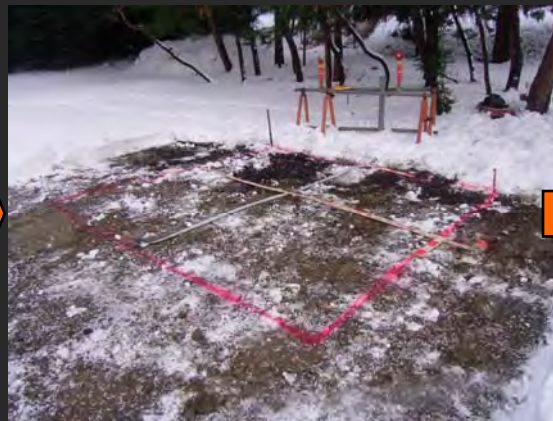
地盤改良前 (3m x 3m)
