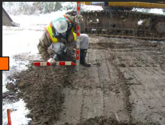
地盤改良面仕上げ
