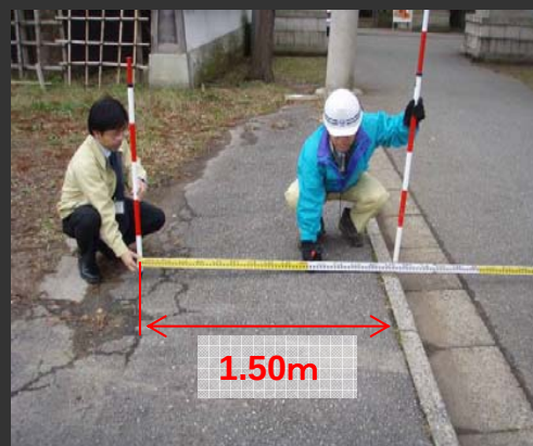
現況参道の幅員を実測
