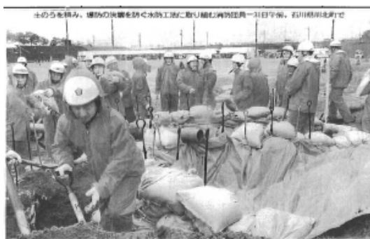
土のろも積み、堤防の決壊を防ぐ水防工法に取り組み水防団員(31日午前、石川県川北町)
