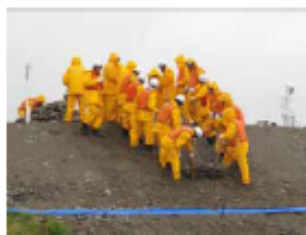
水防団による水防工法
