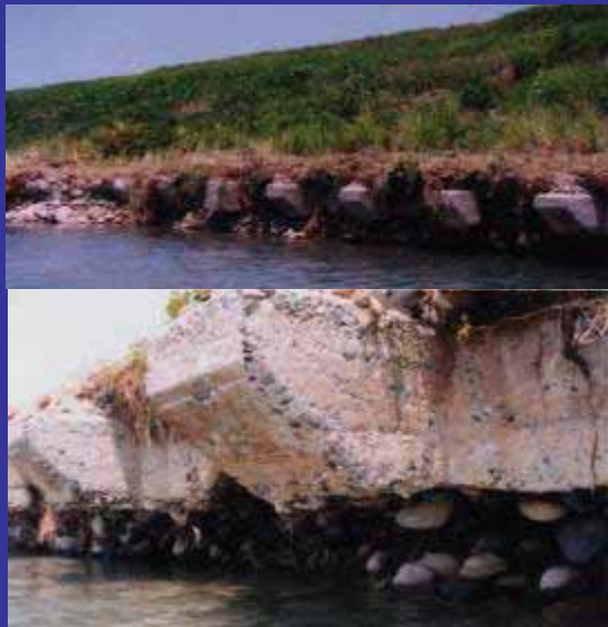
出水による護岸の根の浮き上がり状況 (1997(H9)年7月17日洪水、 Q=1,880\text{m}^3/\text{s} )
