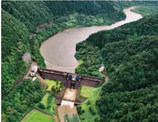
洪水調節により、埴田水位観測所において、水位を0.91m低下させた洪水調節中の赤瀬ダム (平成18年7月16日撮影)
