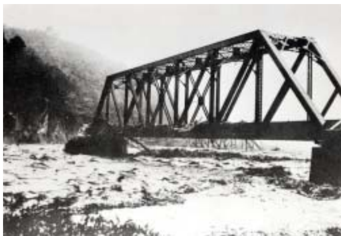
昭和 9 年 7 月洪水（天狗橋[県]流出状況）
