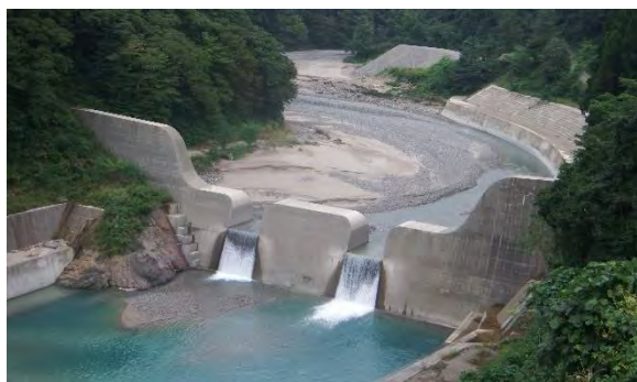
瀬戸砂防堰堤（平成 26 年 3 月竣工）
