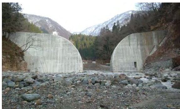
尾添川砂防堰堤（平成 20 年 1 月竣工）
