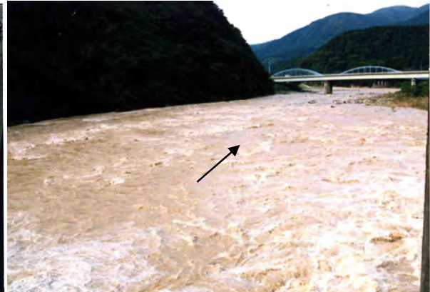
白山合口堰堤下流の状況
