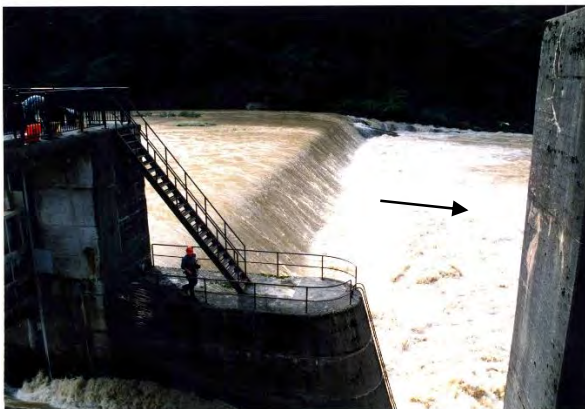
白山合口堰堤の状況
