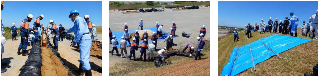
図 9-6 水防工法演習の実施状況
