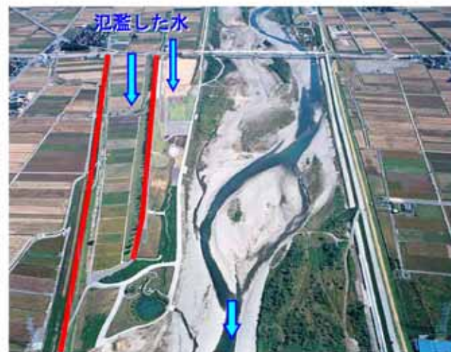
図 76 手取川の霞堤 (川北町与九郎島地先 右岸 6.6k 付近)
