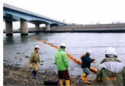
図 75 河口部オイルフェンス設置状況 （ロシアタンカー重油流出事故 平成9年1月）
