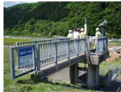
図 77 河川管理施設の点検
