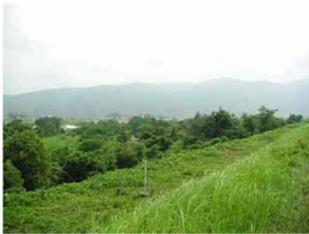
図 64 河道内樹木群の繁茂状況
