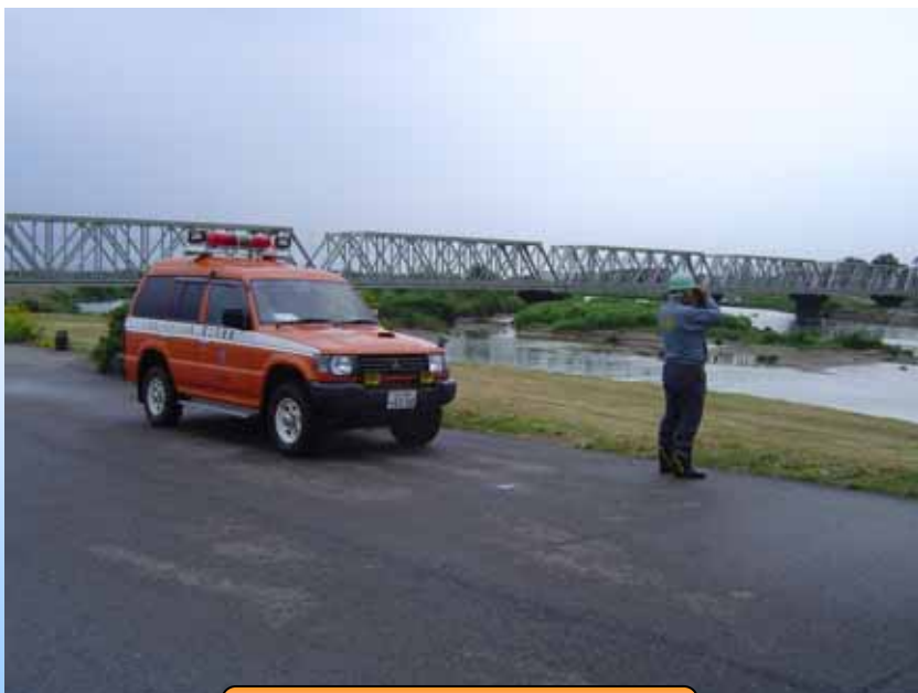
河川巡視状況
