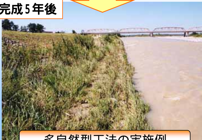
多自然型工法の実施例
