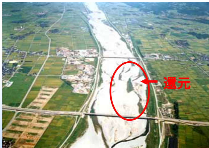
還元箇所の様子(昭和56年8月) 能美市粟生地先4.0k付近
