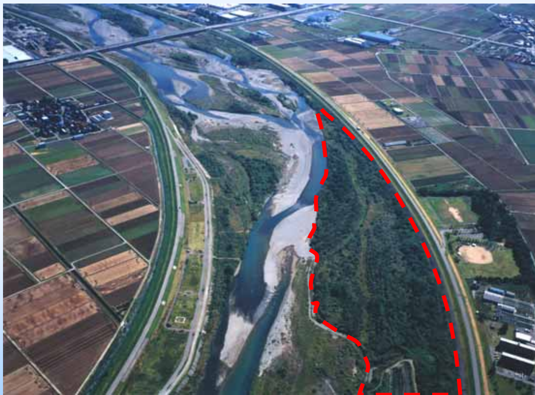
河道内樹木群の繁茂状況 川北町朝日地先2.0k付近
