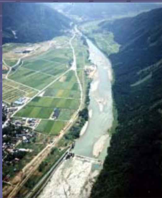
白山合口堰堤付近
