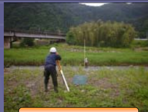
横断測量実施状況
