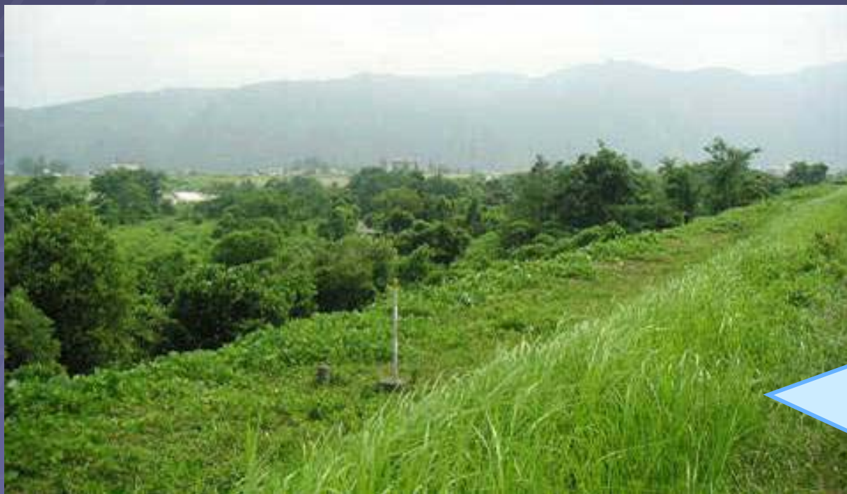
河道樹木の繁茂状況
