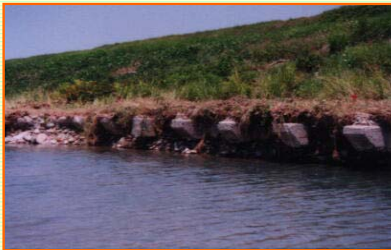
出水による護岸の根の浮き上がり状況 (1997(H9)年7月17日洪水、 Q=1,880\text{m}^3/\text{s} )
