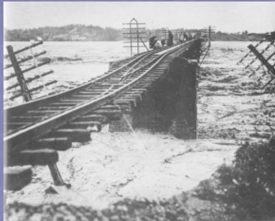
国鉄(現JR)手取川橋梁の被災状況
