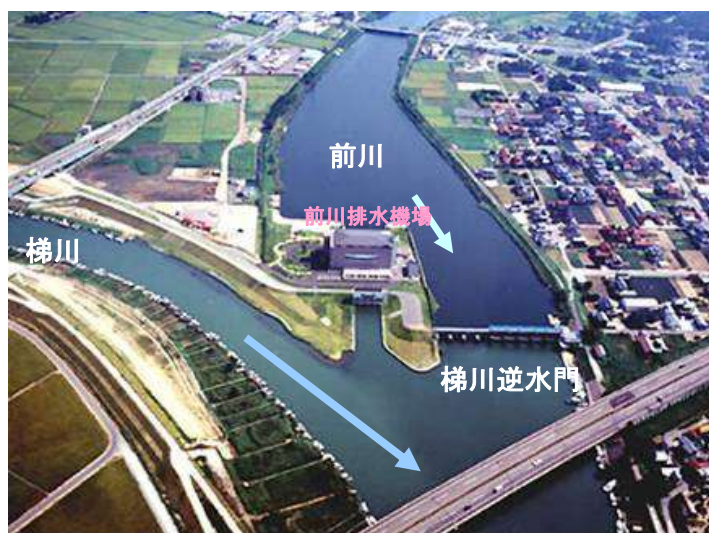
前川排水機場
