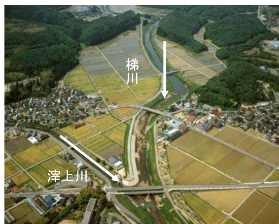
滓上川合流部(河口より 10.7km) 付近
