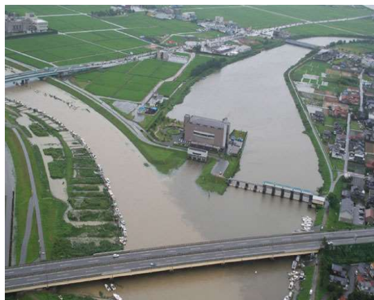
前川排水機場
